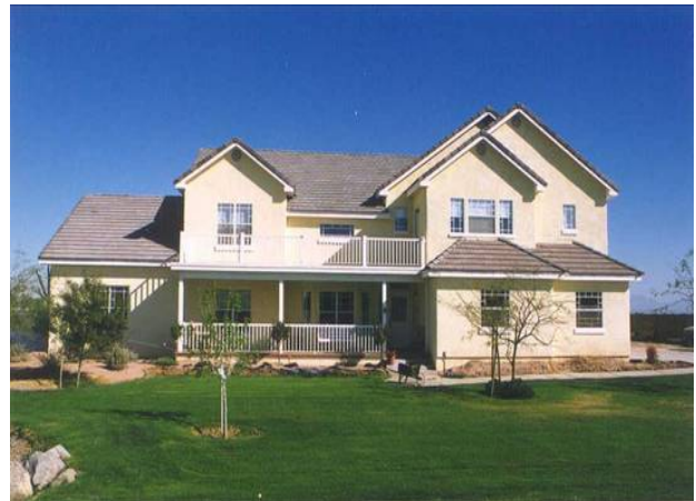
Actual ICF Block Home
