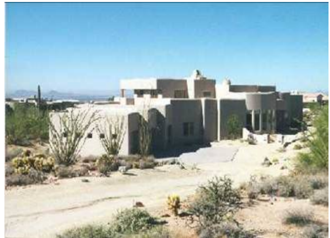
Actual ICF Block Home
